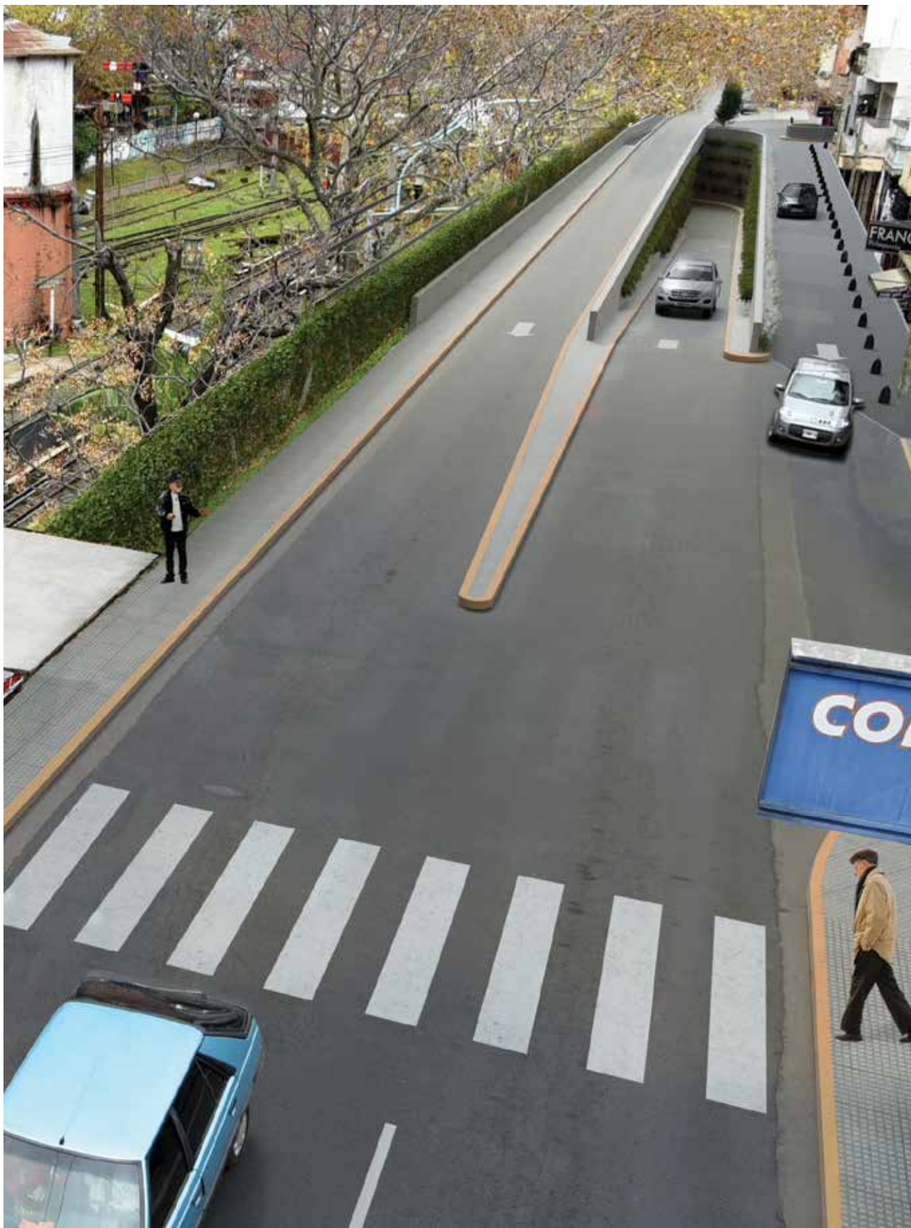
Salida del Paso Bajo Nivel por la calle San Martín.
